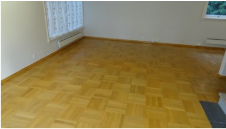
Etter reperasjon og gulvsliping med lakkering med Bona Traffic
